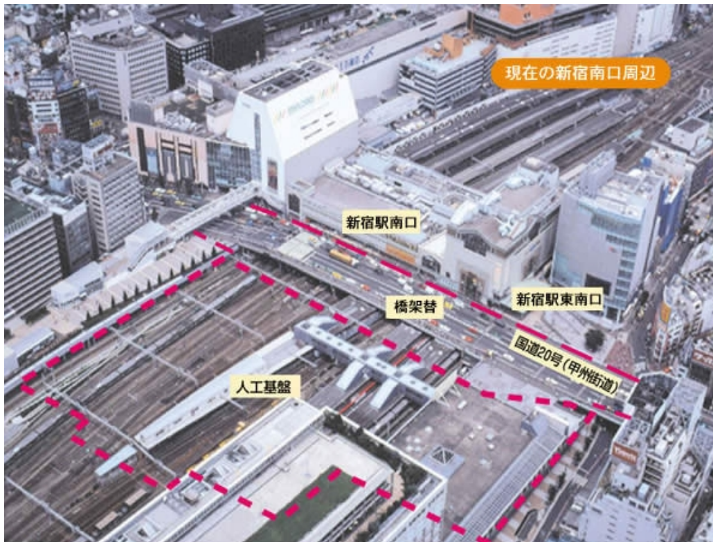
図4：南口基盤整備（写真）
